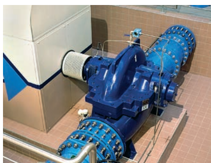
Насос для водоснабжения (насос KSB, Франкенталь)
